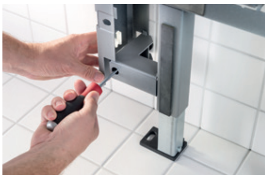
↑ Kaksi säätöruuvia helpottavat asennusta epätasaiselle seinäpinnalle.
