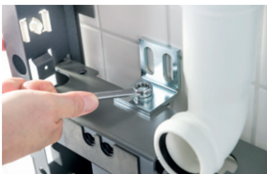
↑ Testatut ja hyväksitodetut kulmakiinnikkeet auttavat kiinnittämään asennuskehiksen seinärakenteeseen.
