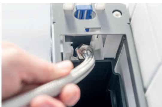
↑ Vahvistettu vesikytkentäletku voidaan asentaa ilman vesisäiliön irrottamista - tämä tekee asennuksen vielä vaivattommaksi.
